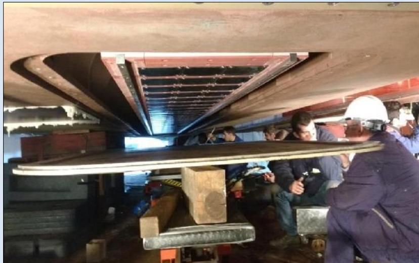
Transductores de Transmisión (96) módulos
